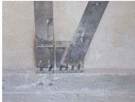
Şekil 4. Bağlantı Detayları
