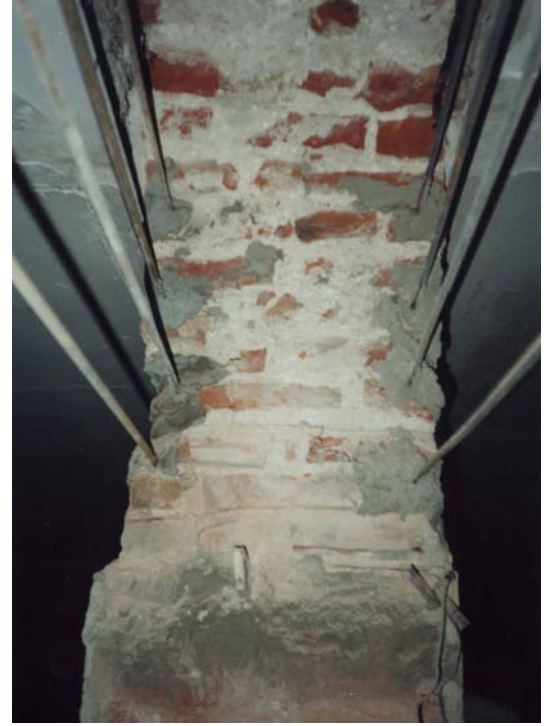
RESİM-2: Hatıl Uygulaması
