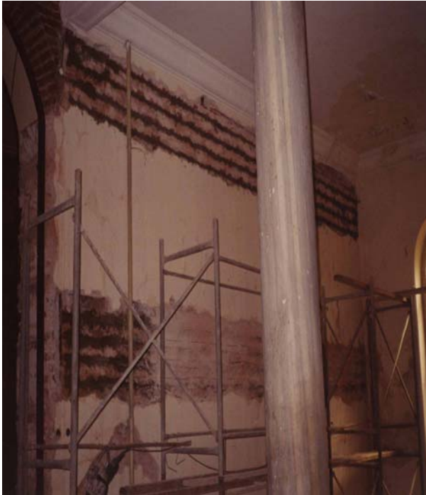
RESİM-3: Duvar Hatıl Bölgesi
