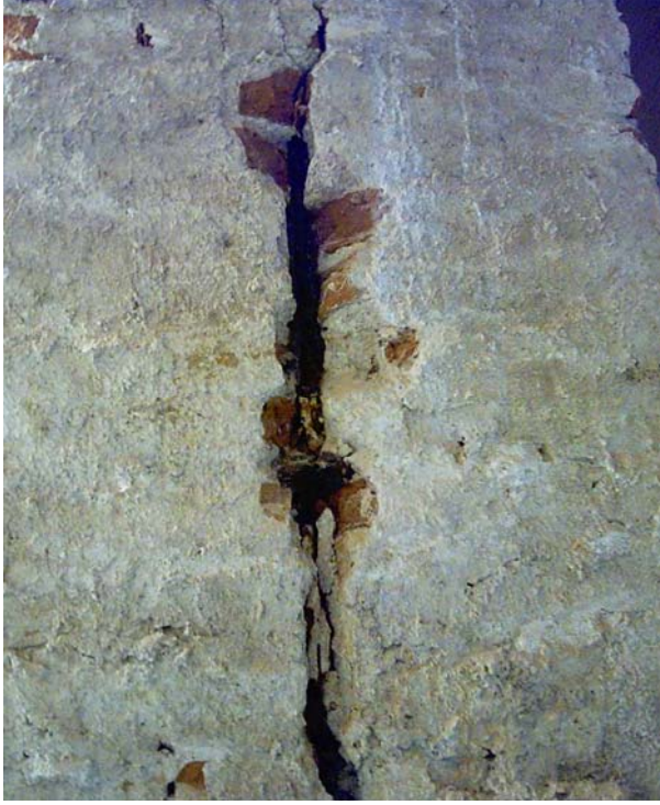
Resim-1: Duvar Hasarı
