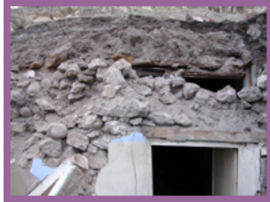
Resim 5 Kalın toprak dam
