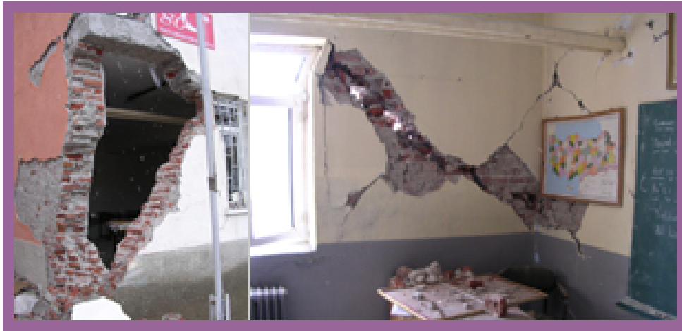
Resim 6 Kandilli Kasabasındaki yüksek hasarlı yığma okul binası
