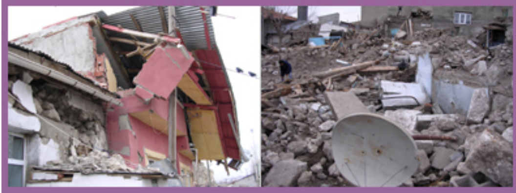
Resim 1 Bir tuğla yığma yapı ve Küçükgeçit köyündeki yıkım
