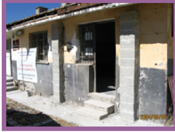
Resim 7 SPIM-1451 kapsamında güçlendirilmiş Antakya Odabaşı Belediyesindeki tuğla yığma kütüphane ve okul binası
