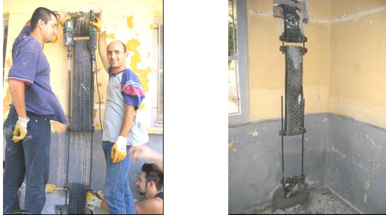
Şekil 9: Lastiklerin Gijon ve Somun Vasıtasıyla Gerdirilmesi
