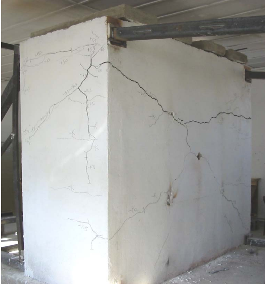
Şekil 6. Düzlem Dışı Yüklenen Duvarın Kırılma Deseni
