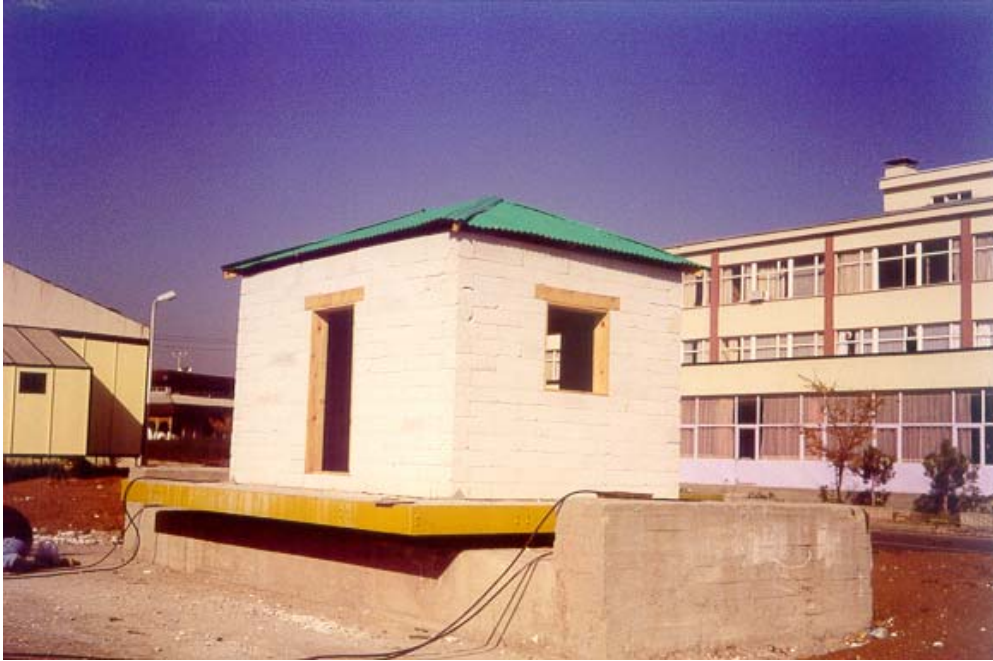
Şekil 4. Geliştirilen mekanik tasarıma uygun olarak kesilen Ytong blokları ile inşa edilen gerçek boyuttaki tek katlı yığma ev.
